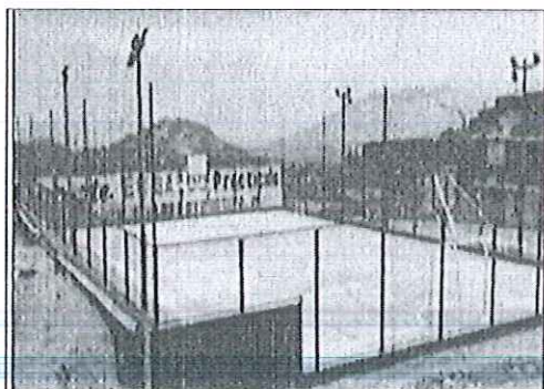
Remodelación de la losa deportiva Las Flores (Zona Pachacutec)
